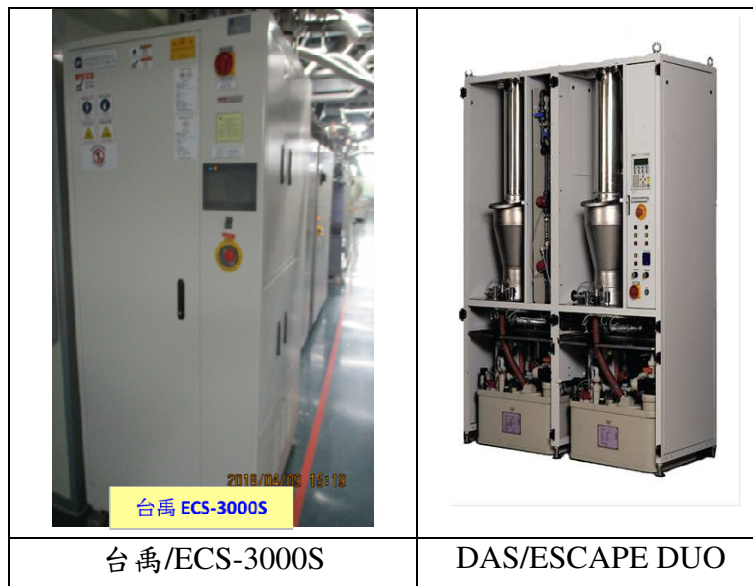
圖 5 本專案使用之燃燒水洗式尾氣處理設備
